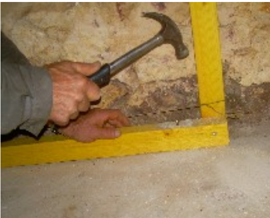
2 - Fixer les chevrons au sol avec des tire-fonds ou des vis à frapper.
