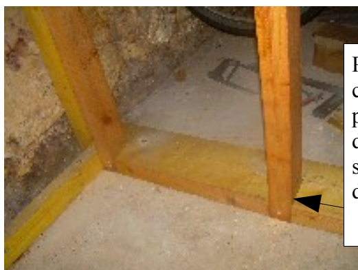
2 - Fixer les chevrons au sol avec des tire-fonds ou des vis à frapper.
